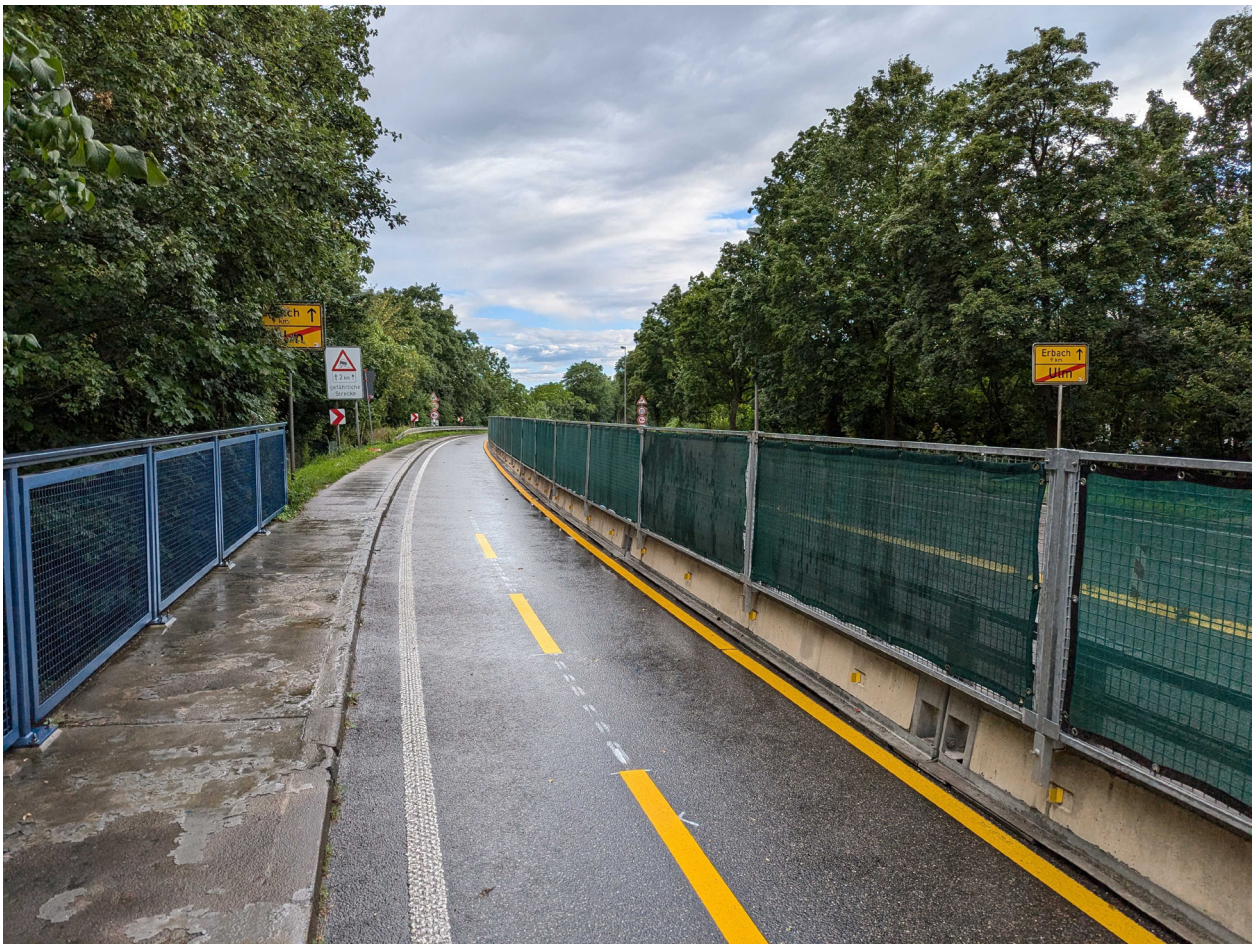
Radweg Höhe Galgenbergweg, Quelle: Stadt Ulm
